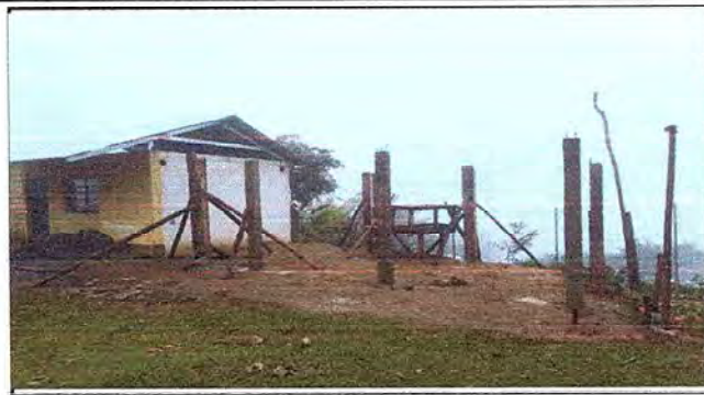
Foto 2: SUSTITUCION DE ENTECHADO DE COCINA
