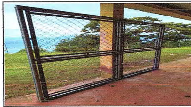
Foto 4: SUSTITUCION PORTON DE ENTRADA DEL ESTABLECIMIENTO
