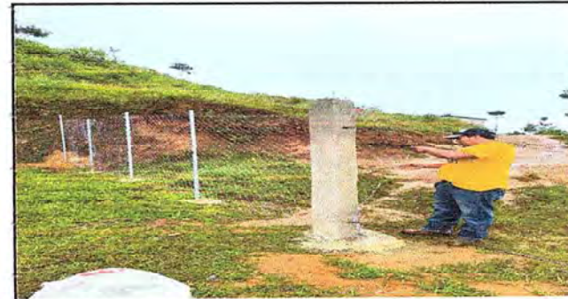
Foto 6: SUSTITUCION DE MAYA PERIMETRAL
