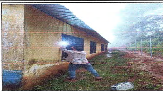
Foto 1: SUSTITUCION DE VENTANALES
